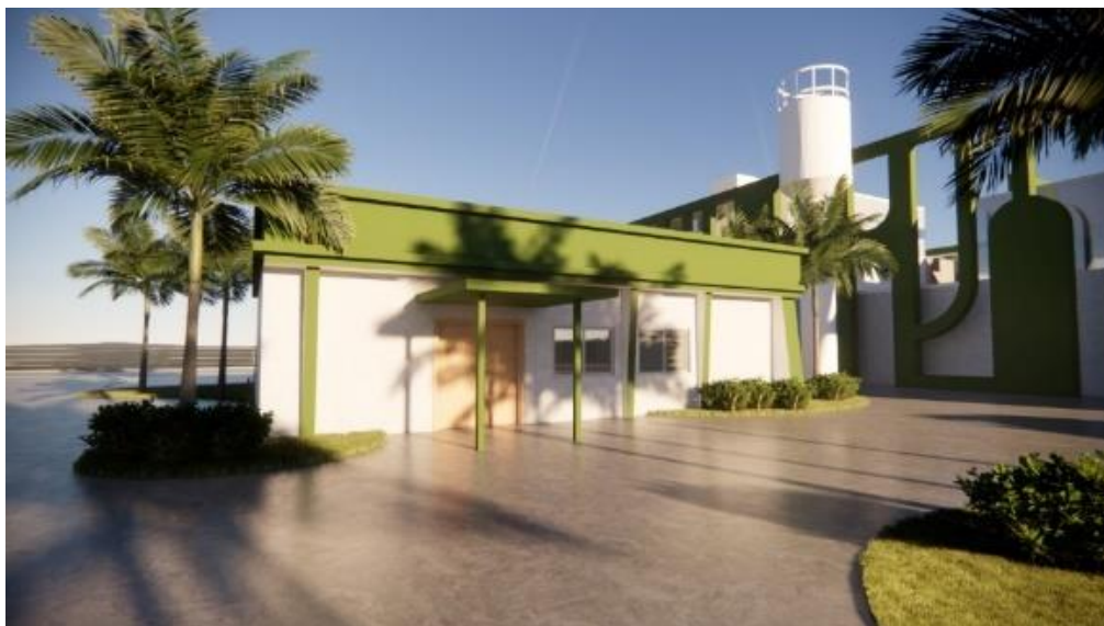
Figura 9 - Restauração do antigo TPS.
