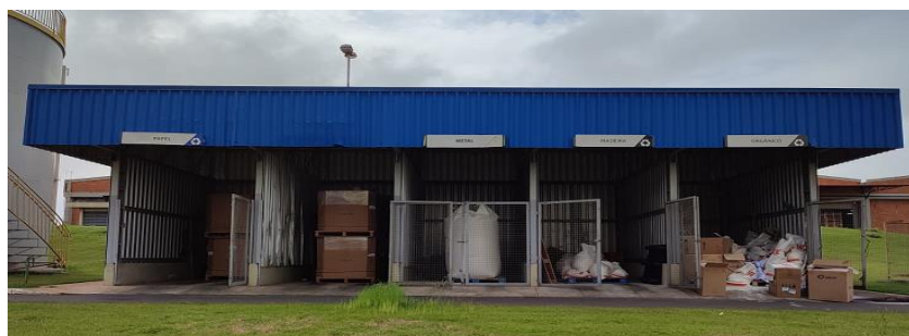
FIGURA 06 – Novo local de armazenagem. FONTE: dados obtidos pelo autor, 2022
