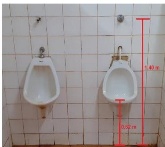
Figura 25 – Mictório sem barras de apoio e inconformidade medidas
