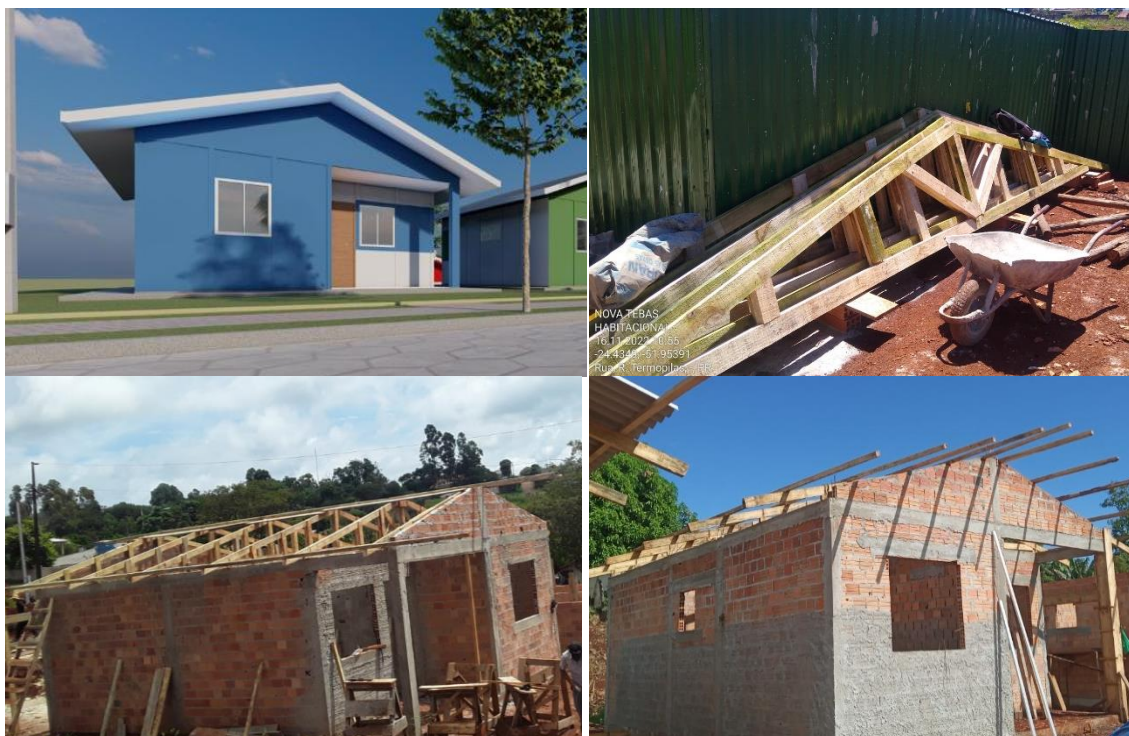
Figura 6: Casa popular construída pela Prefeitura Municipal de Nova Tebas e a respectiva fase de construção do madeiramento do telhado.
