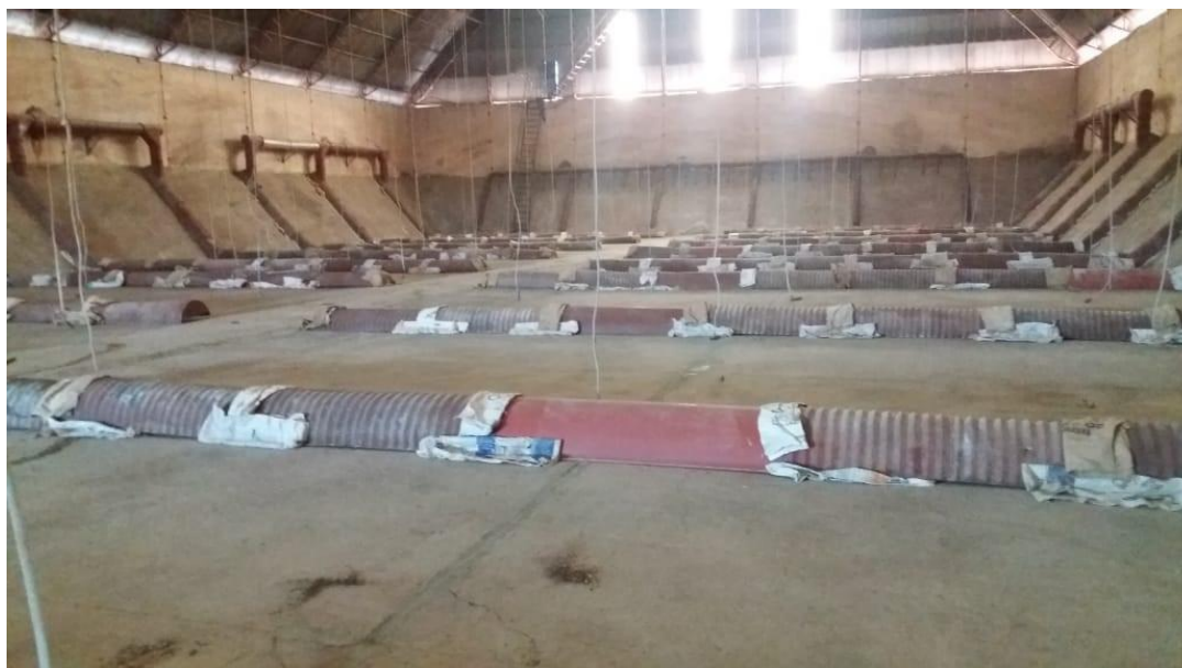
Figura 1 – Armazém Semi-V com dutos metálicos. Fonte: Autor
