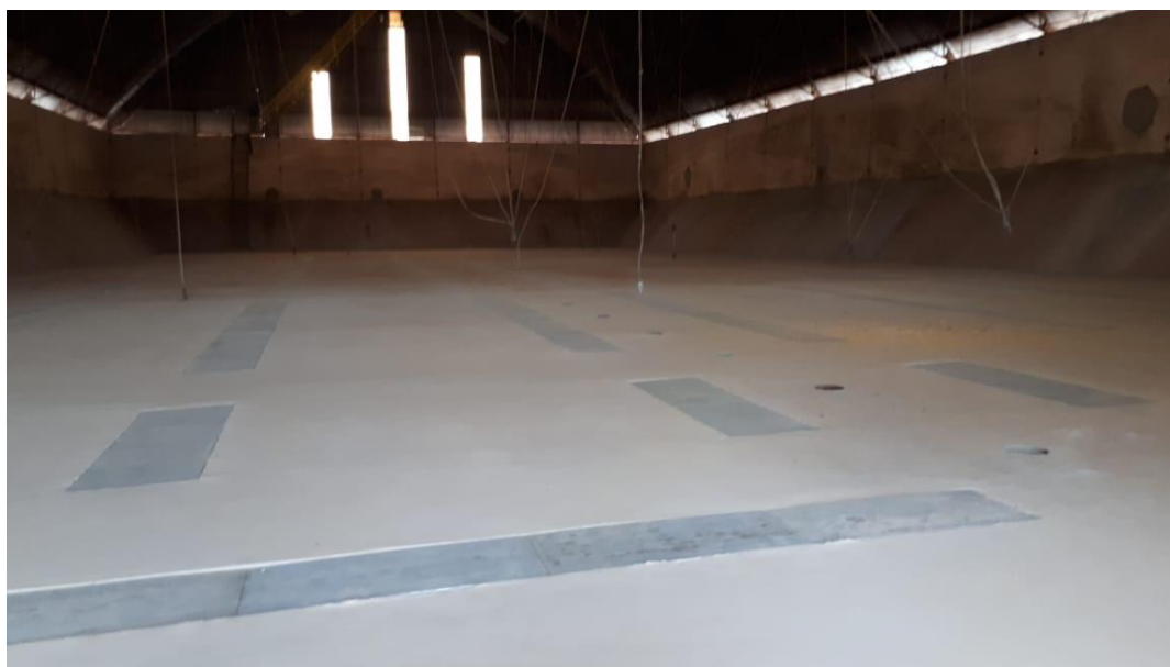
Figura 2 - Armazém Semi-V com dutos metálicos. Fonte: Autor
